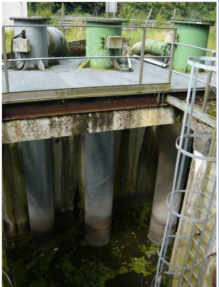
Bâche EP et pompes
