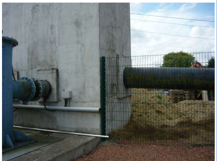
Rejet vers réseau
