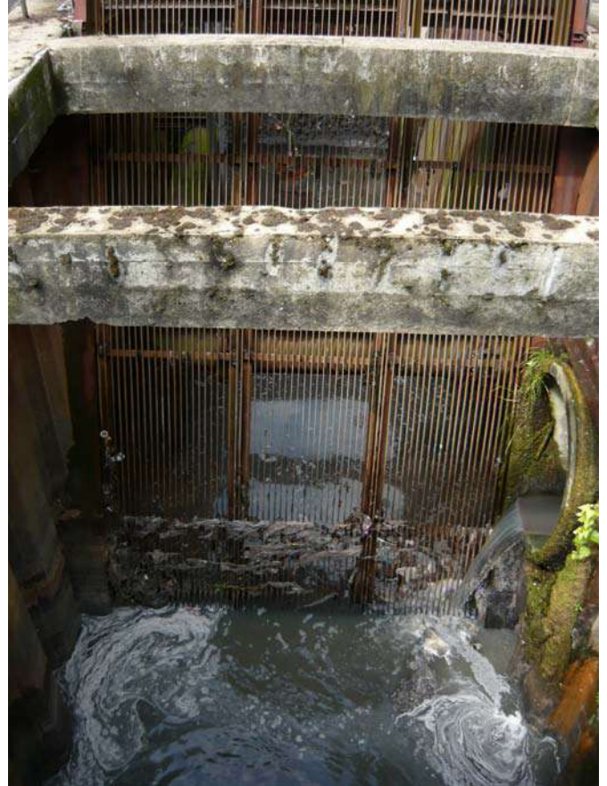
Entrée et double dégrillage
