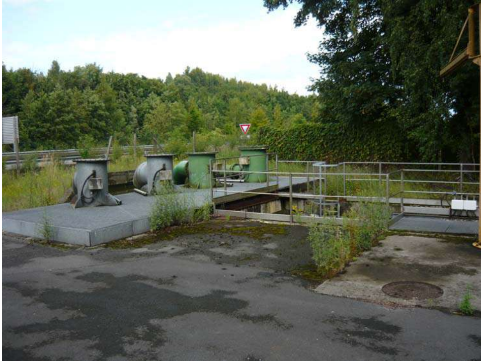
Vue générale de la station
