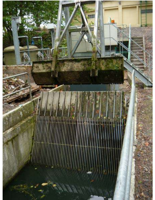
Entrée et dégrillage
