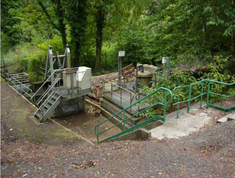
Vue générale de la station (extérieur)
