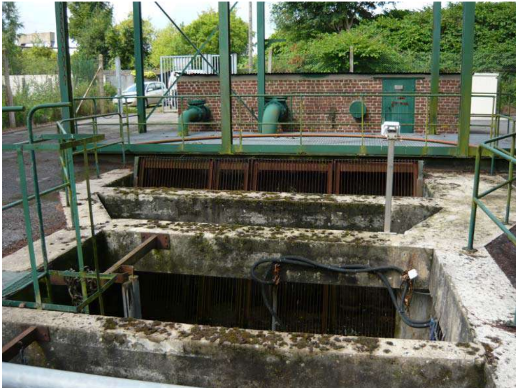
Dégrillage et pompes
