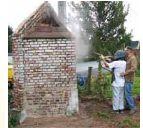
nettoyage à l'eau à haute pression
