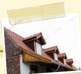
répétition de lucarnes trop larges (à éviter)
