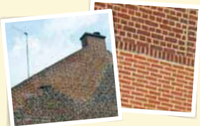
différence de nuances de briques à harmoniser par un badigeon
