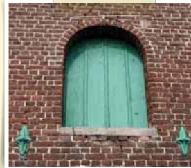
joints blancs sur un bâtiment agricole
