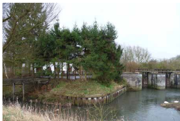
Écluse de Rodignies (ancien Escaut)
