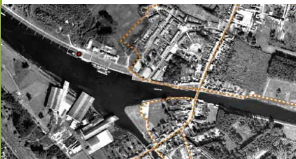
1989 : creusement de la confluence, disparition d'un pont
