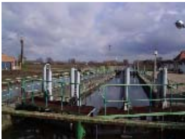
Ecluse de Warlaing
