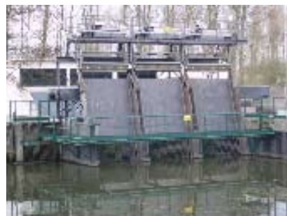
Stations de pompage (canal Broutin et Anguille)
