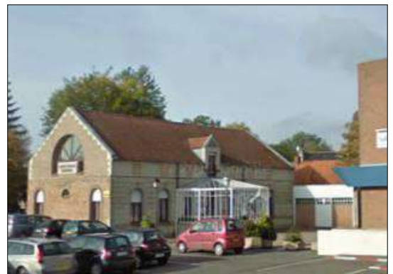
École Pierre Brossolette, collège et Mairie constituent des équipements publics importants
