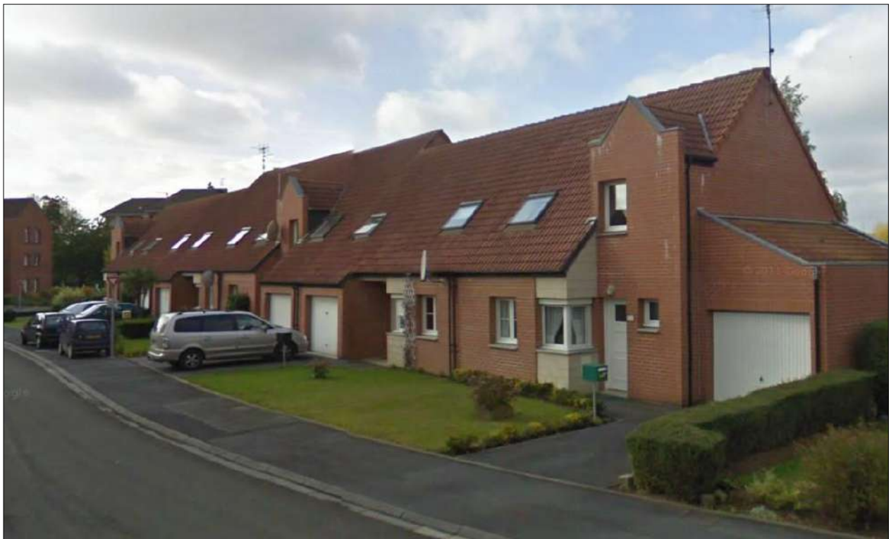
Des constructions mitoyennes récentes rue Alexandre Desrousseaux
