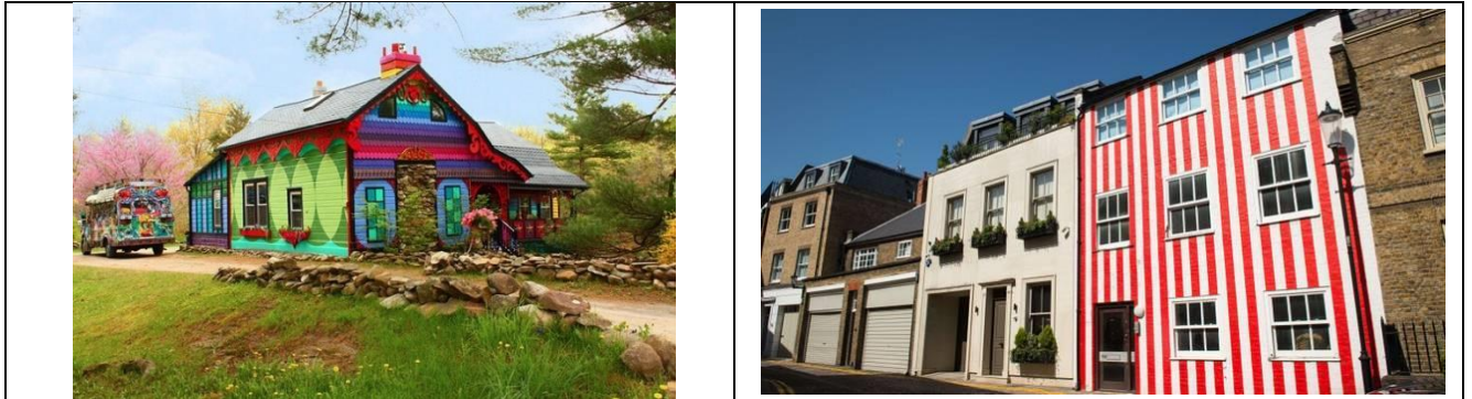
Exemples de traitements en façades interdits
